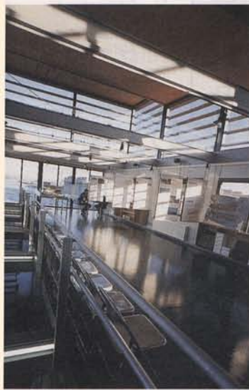
Uitzicht Vanuit het paviljoen geven grote glazen puien goed zicht op de wooneilanden in wording. Ook de optredes van het trapsgewijze dak zijn van glas. Als zonwering zijn houten steigerplanken horizontaal bevestigd.
