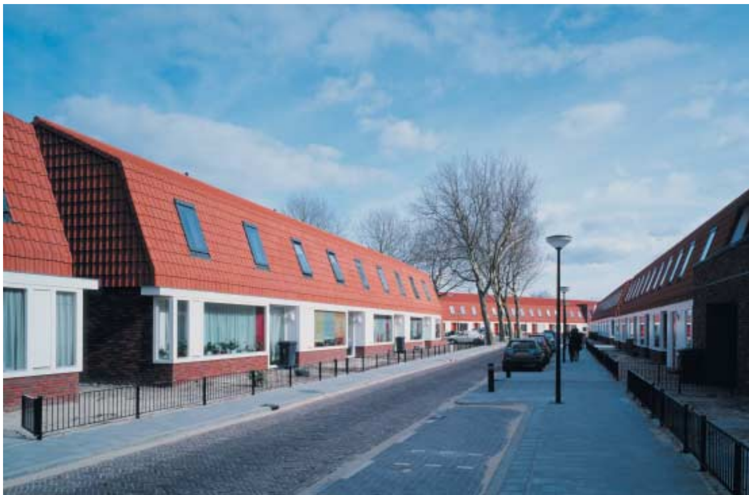
Van een afstand domineren de daken het beeld. Dichterbij blijkt dat de helling van het bovenste dakvlak zo is gekozen dat hij buiten het gezichtsveld valt. In het straatprofiel lijken de woningen daarom lager dan ze in werkelijkheid zijn, wat bijdraagt aan de kleinschaligheid van de wijk.
